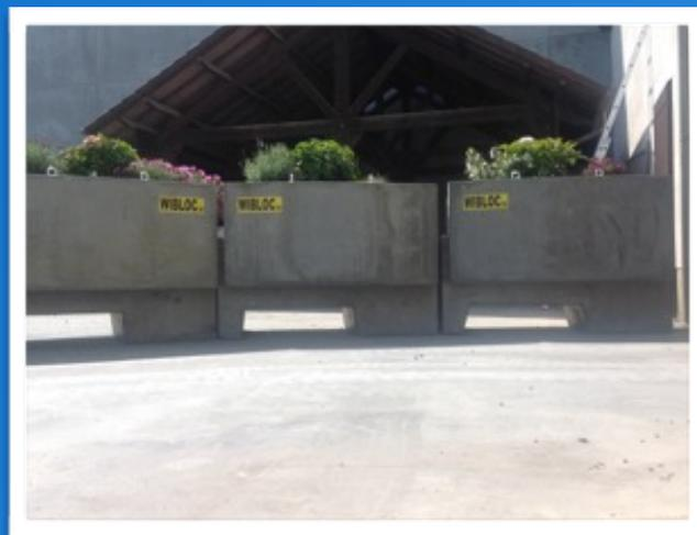
Des blocs de béton reliés entre eux, avec des bacs à fleurs posés dessus, ferment la rue et ne donnent pas aux visiteurs l'impression qu'ils doivent se cacher derrière un mur en béton. Où sécurité et d'élégance se retrouvent...
