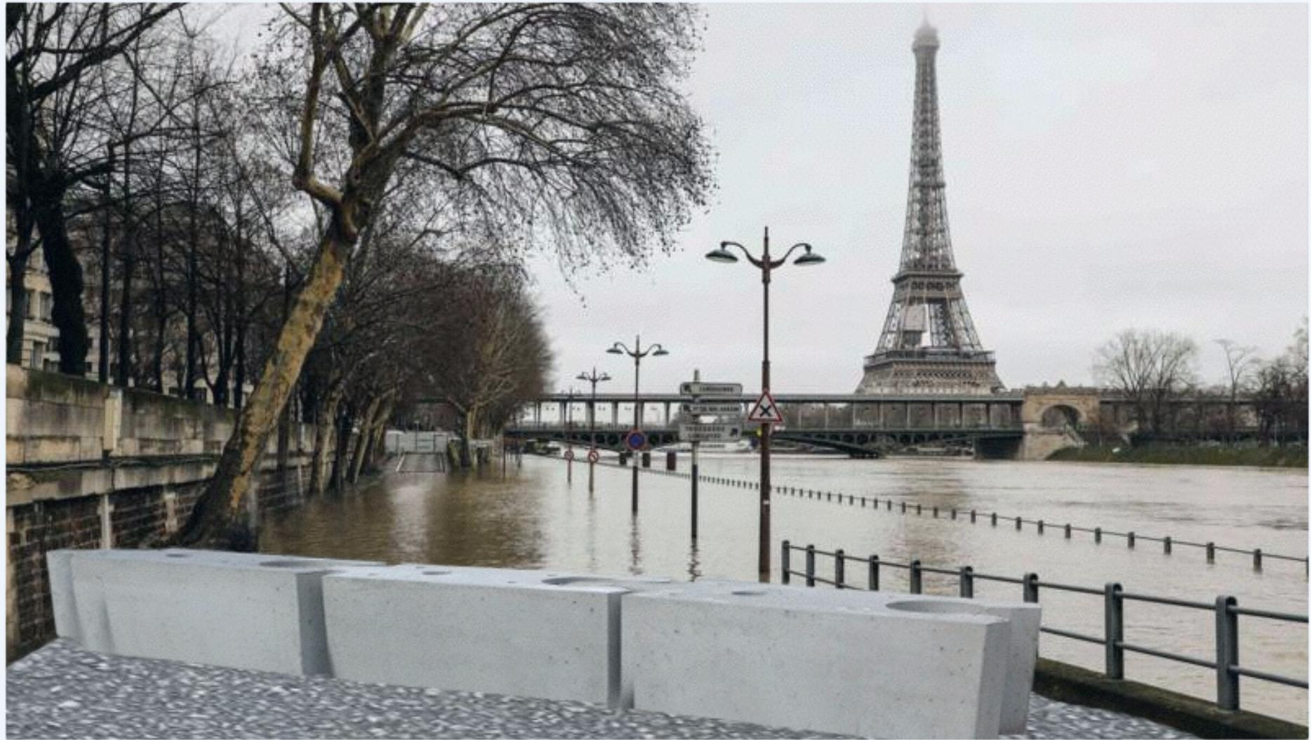
Le Wibloc peut être rendu étanche grâce à des joints en caoutchouc spéciaux. Les blocs de béton forment alors un mur impénétrable en cas d'inondation. Facile à utiliser et économique...
