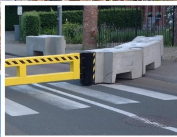
Une différence de hauteur entre la chaussée et le trottoir ne pose pas de problème pour placer les blocs.
